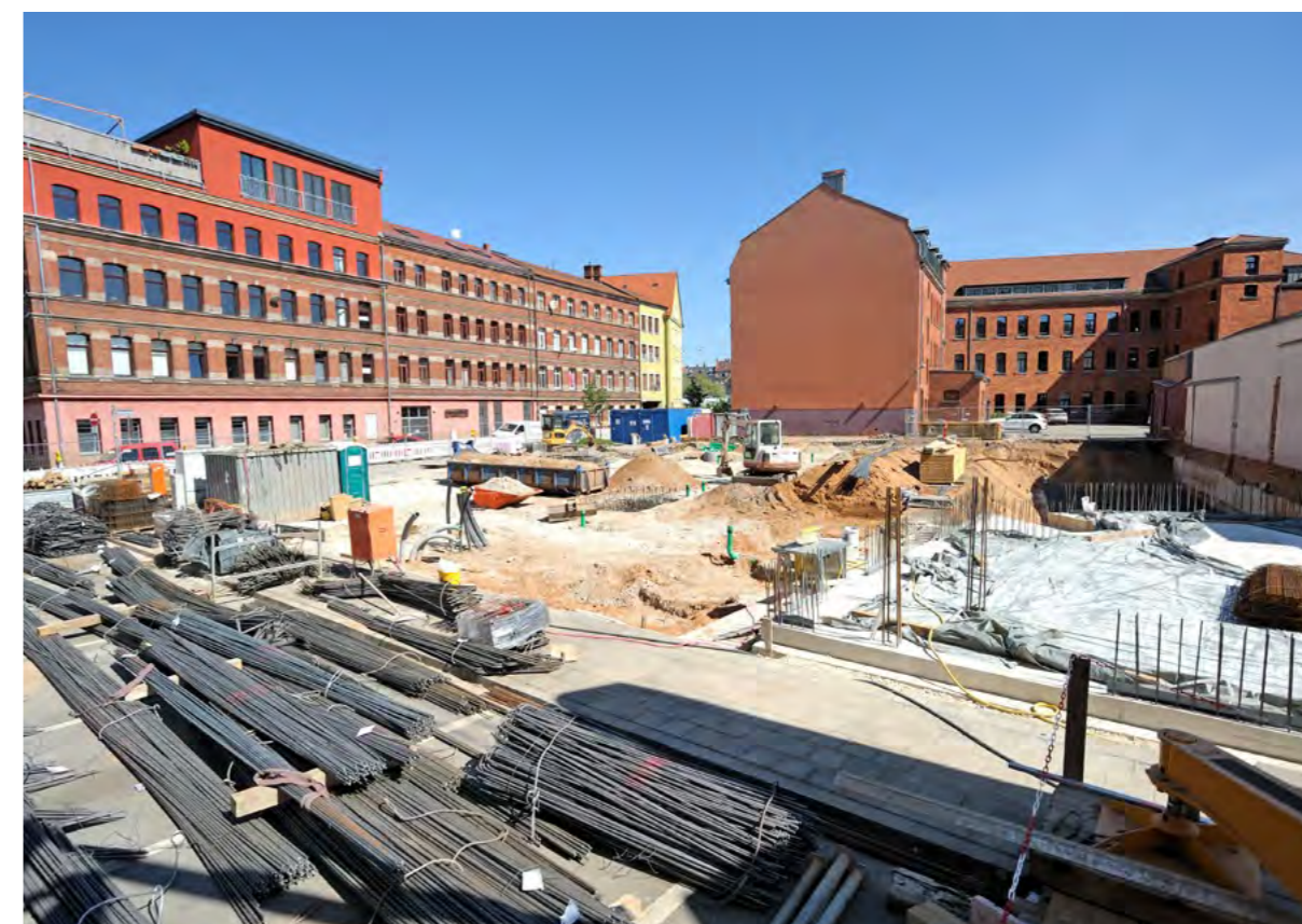
Baustelle Neubau Kaiserstraße 166
