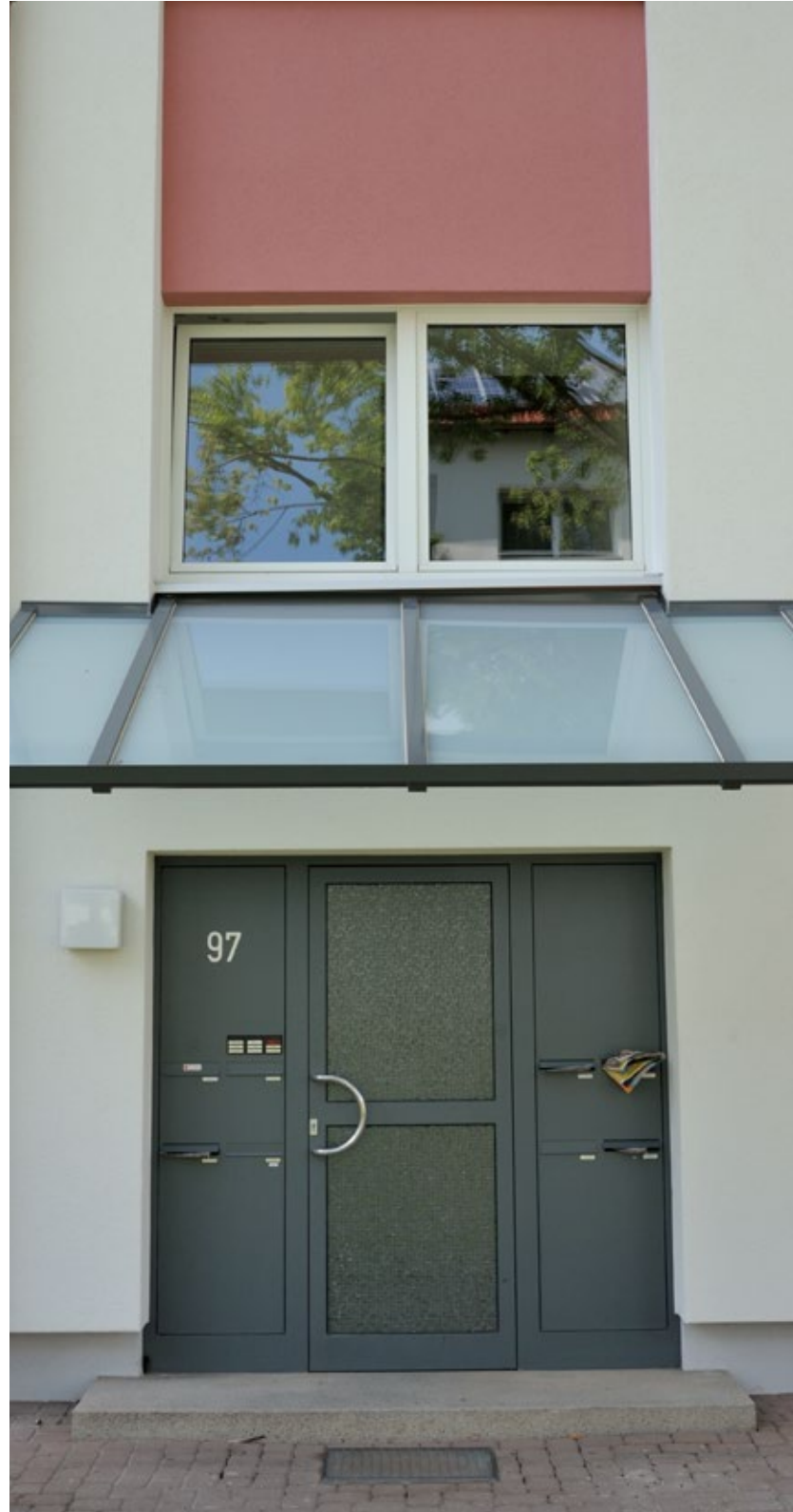
Im Bereich der Soldnerstraße lief das Sanierungsprogramm 2014 an. Das Ergebnis darf man als modern und gelungen bezeichnen.
