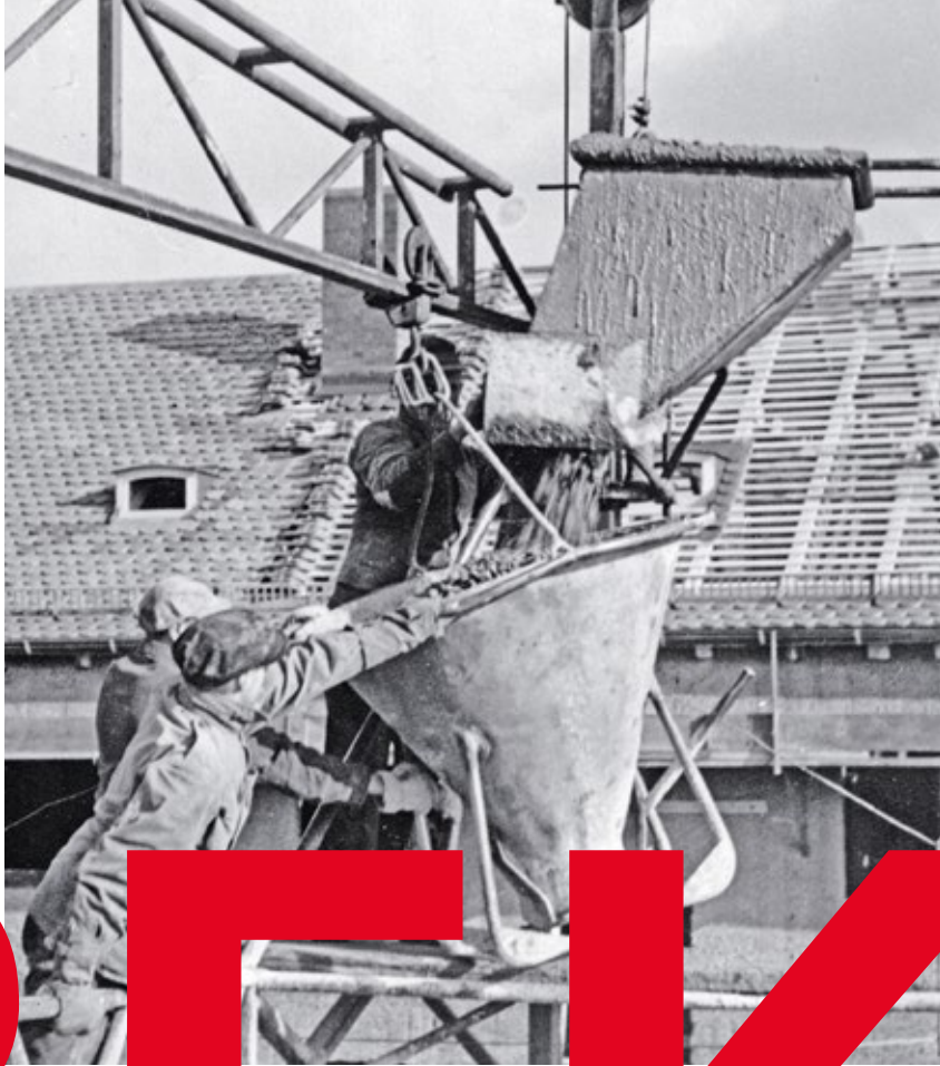
Schüttbeton im Wohnungsbau einzusetzen, war Ende der 1940er/Anfang der 1950er Jahre relativ neu.
