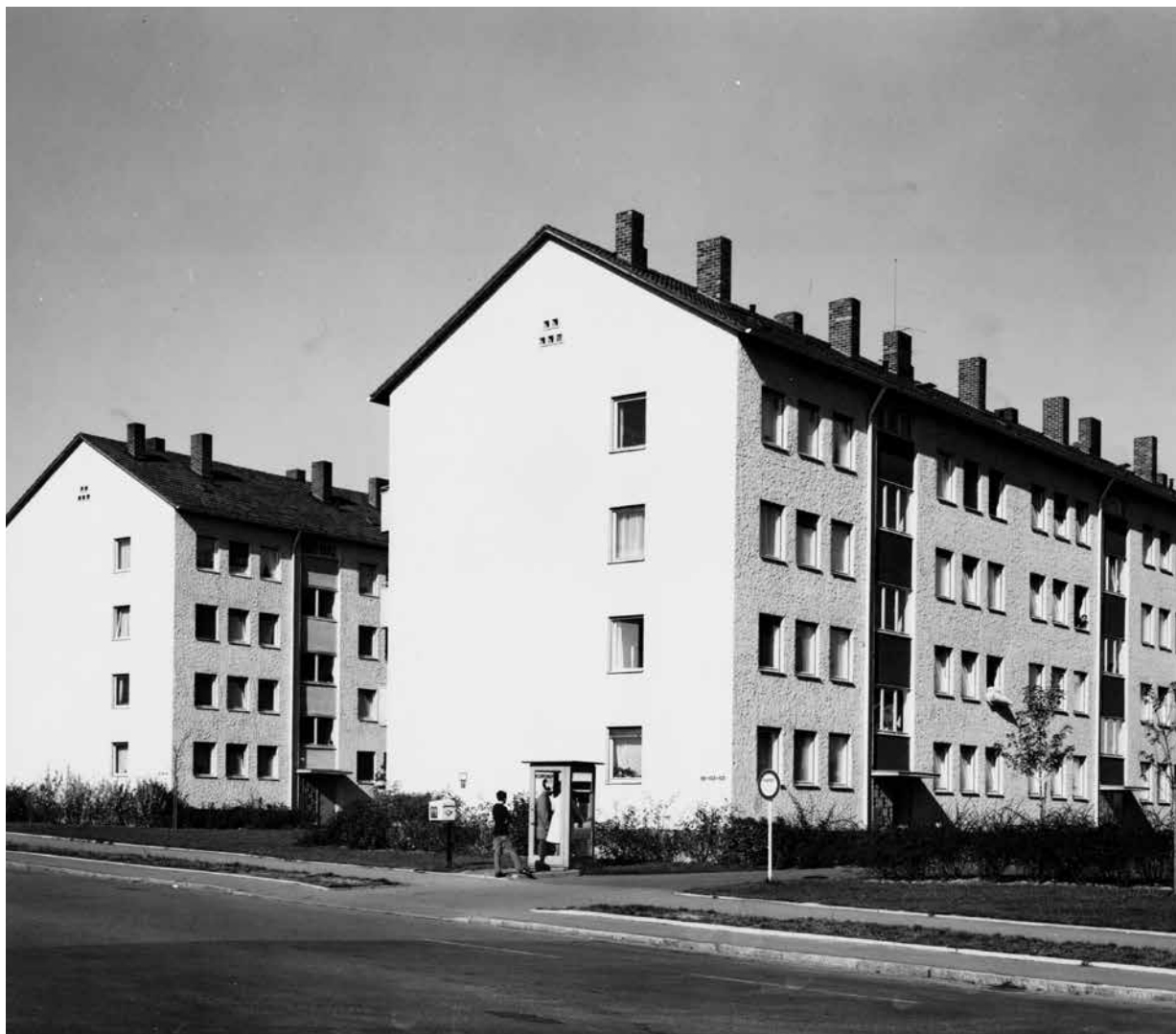
Zeilige Baukörper ohne architektonische Schnörkel waren in der „BRD“ typisch für den Wohnungsbau der 1950 und 1960er Jahre. Es galt, möglichst viel kostengünstigen Wohnraum zu schaffen. Links Gebäude an der Soldnerstraße, rechts der Abzweig Reichenberger Straße.
