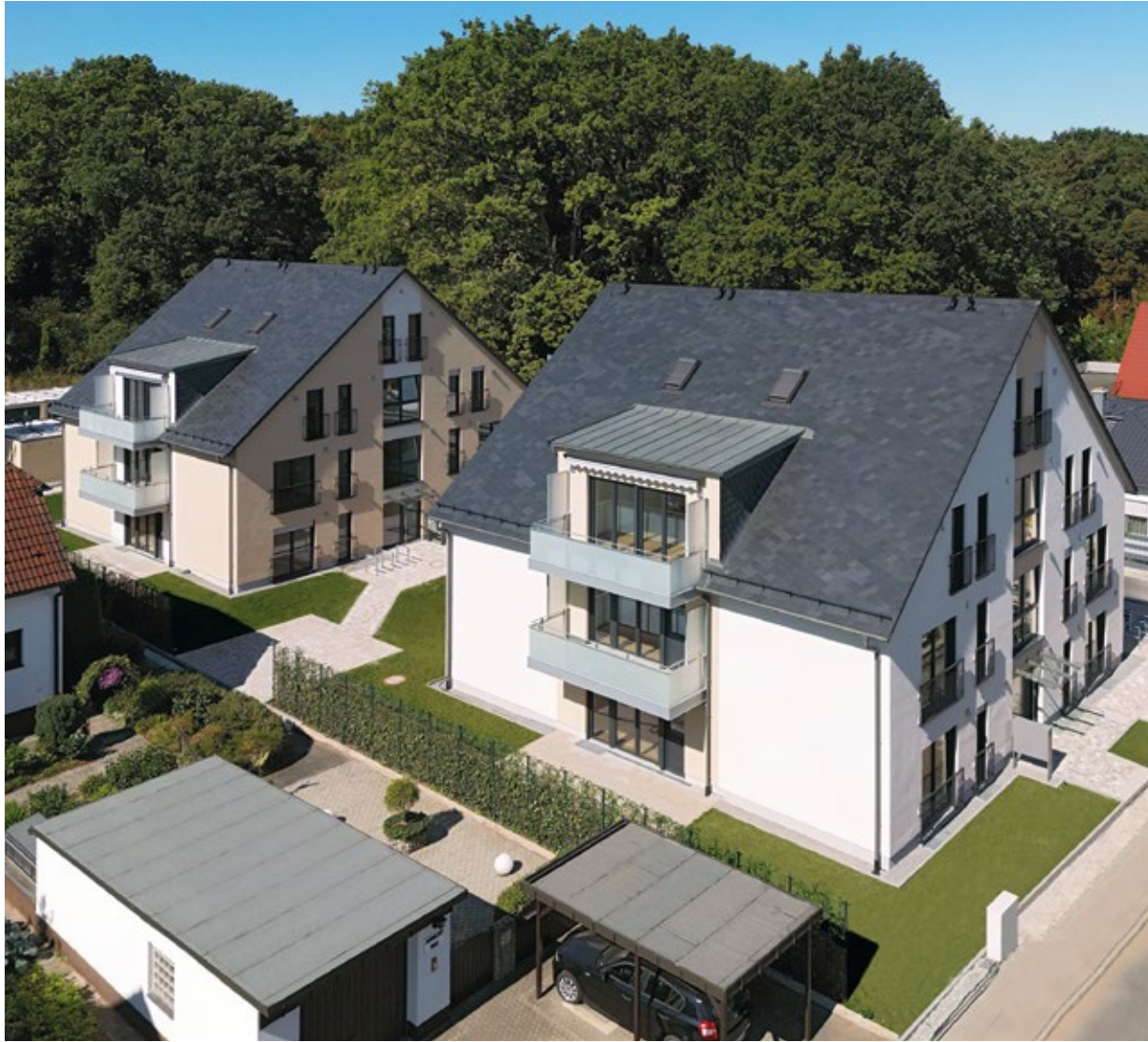
2022 errichtete die Genossenschaft in der Ronhofer Hauptstraße 267/269 (Fürth), direkt am Ronhofer Wäldchen, 20 moderne, energieeffiziente Wohnungen. Sie werden ausschließlich mit einer Luftwärmepumpe beheizt. Aus Photovoltaik-Anlagen auf den Garagen beziehen die Bewohner preisgünstigen Ökostrom für die Durchlauferhitzer. In der Hainbergsiedlung (Oberasbach) entstehen 20 weitere Neubau-Wohnungen und eine Autotiefgarage.
