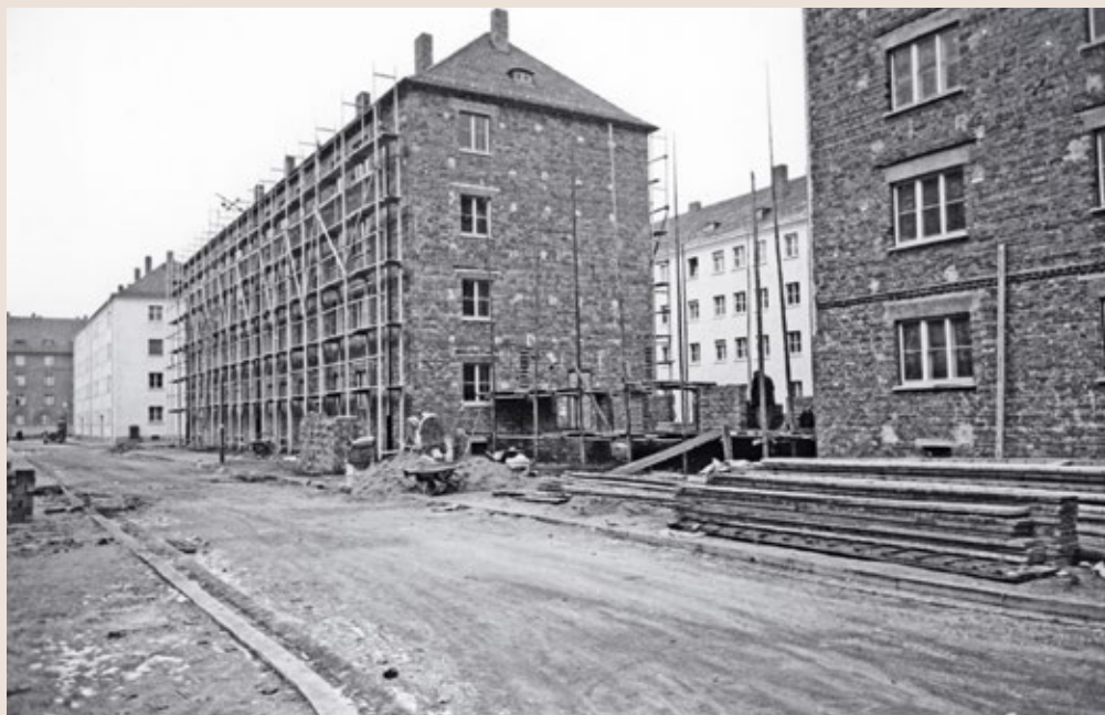
Wohnhaus um Wohnhaus wurde auf der ARGE-Großbaustelle in Windeseile hochgezogen – ganz überwiegend in reiner Handarbeit (gegenüberliegende Seite), die ein kleines Heer von Bauarbeitern leistete.
