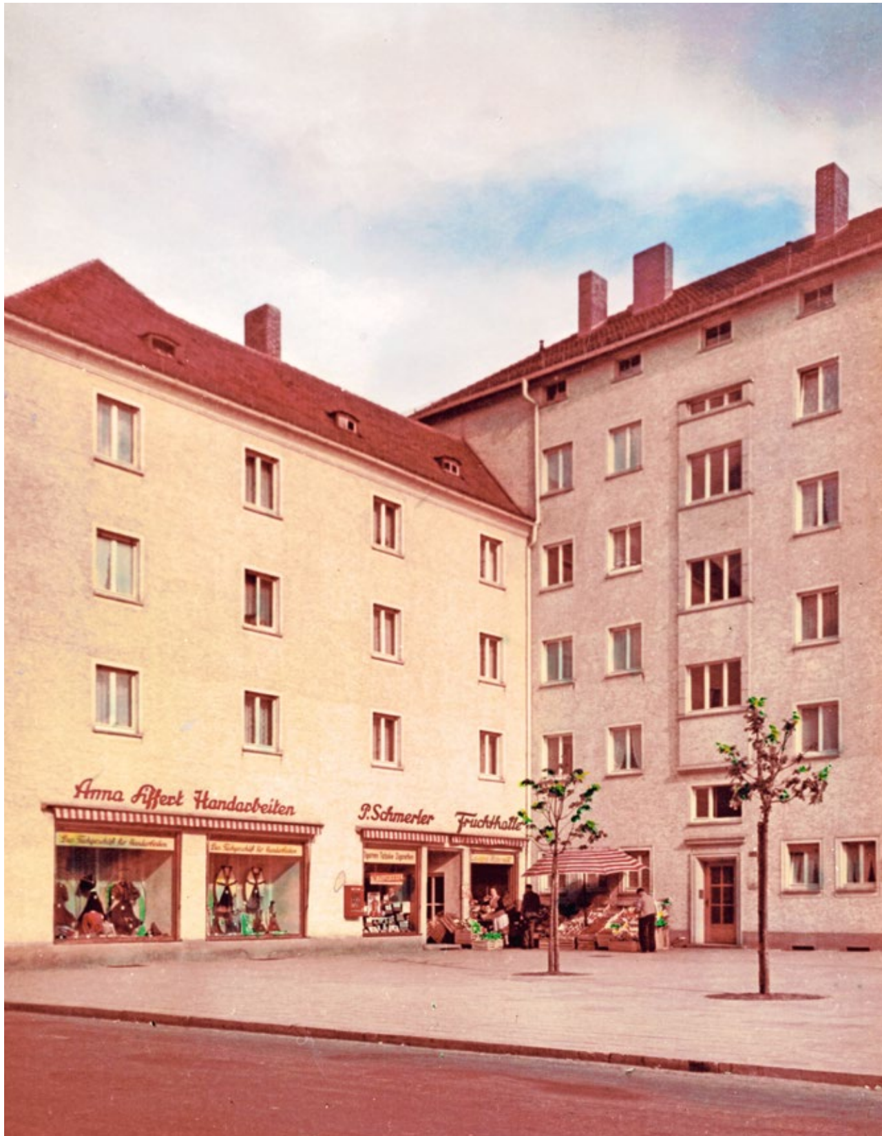
In der Südstadt nahm die Geschichte der Arbeitsgemeinschaft Fürther Baugenossenschaft GmbH (ARGE) ihren Anfang. Die Wohnhäuser dort entstanden im architektonischen Stil des Nachkriegs-Wiederaufbaus.
